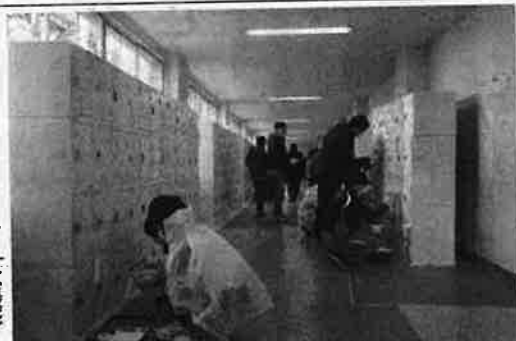
1日目の作業では下足入れにさび止め塗料を塗装
